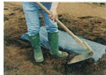
② 同じようにして少しずつ土をかけていき、両サイドを固定します
