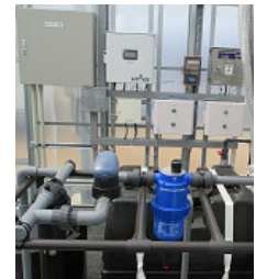
環境制御施設
