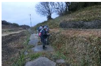
鳥獣防護柵設置作業
