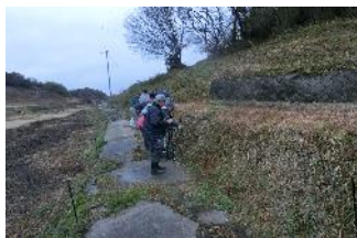
鳥獣防護柵設置作業
