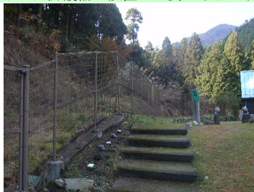
防護柵の設置
