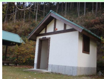
トイレの整備
